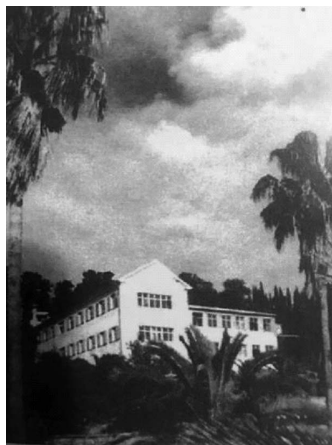
Zgrada Umjetničke škole u Herceg Novom, 1951. godina.
